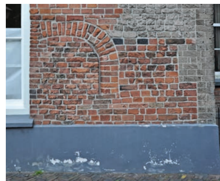
Bouwsproten in metselwerk worden tegenwoordig bij voorkeur zichtbaar gehouden.
