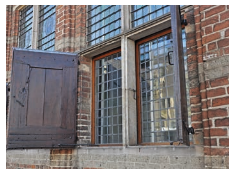
Het bovenaan deze pagina afgebeelde kruiskozijn gezien van buiten
