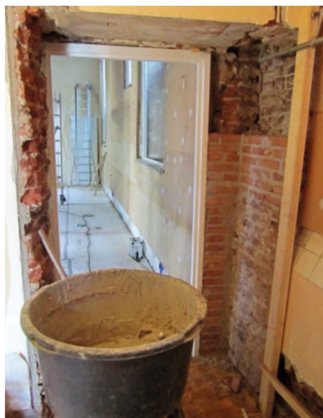
Op de muur wordt eerst een laag leemstuc aangebracht; daartegenaan worden de houtvezelplaten bevestigd
