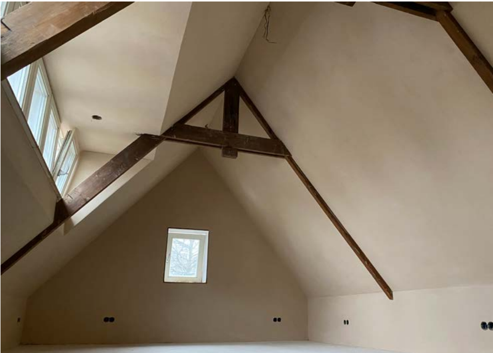
De voorzetwanden in het Toekomsthuisje op het Amsterdamse WG-plein zijn afgewerkt met stroleemplaten en leemstuc.
