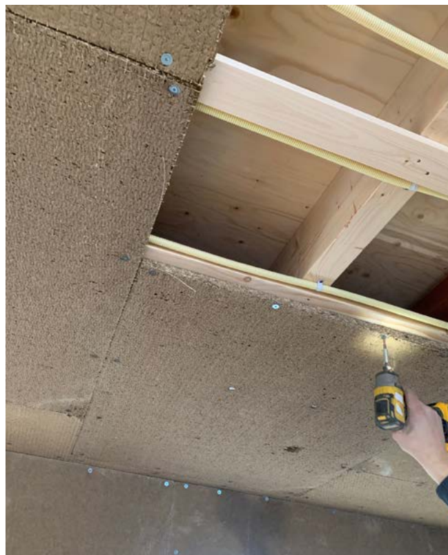
Voor de isolatie van dak en muren is cellulose ingeblazen in het plafond en achter de voorzetwanden.
