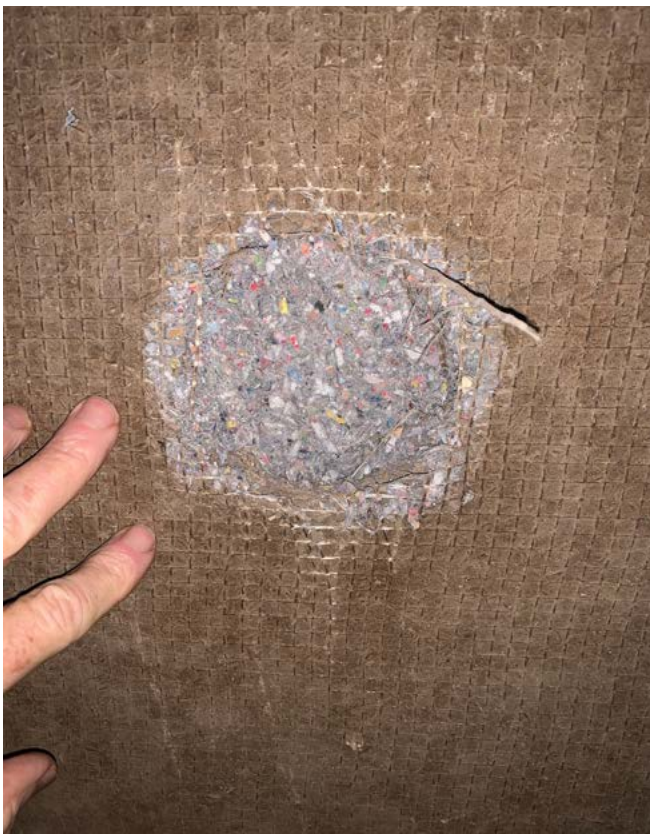
Ingeblazen cellulose
