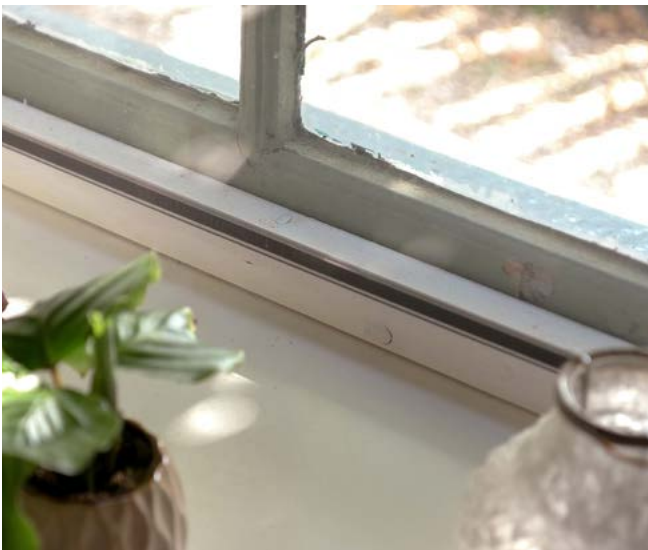
Kierafdichting met tochtstrips
