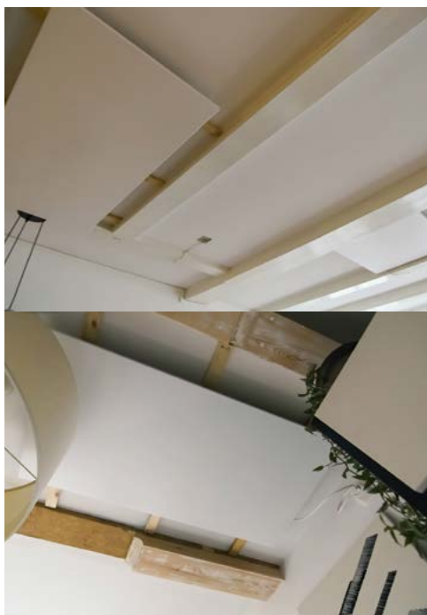
Infraroodpanelen tussen de oude balken
