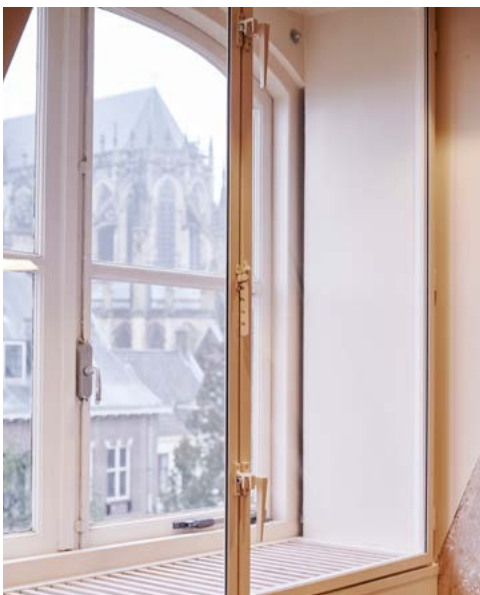
Een voorbeeld van een binnenvoorzetraam dat past binnen de monumentale waarde van het gebouw
